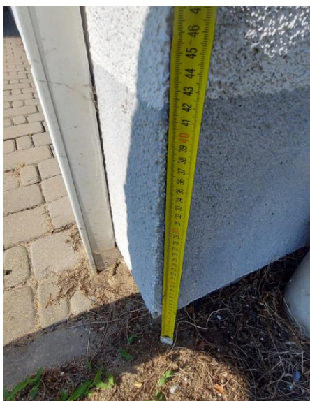
Fot. 25. Określenie wysokości malowania cokołu – 40 cm.
